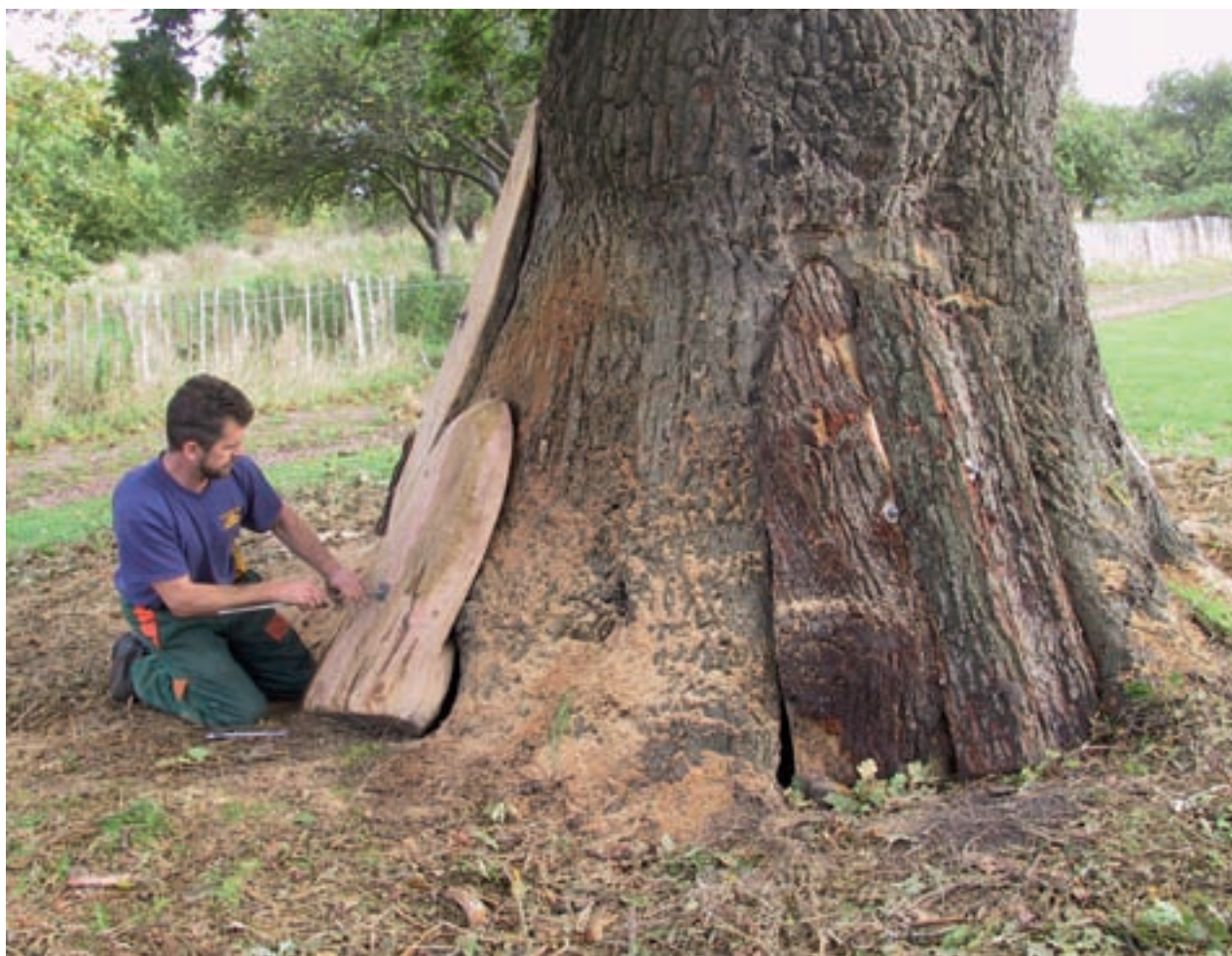
Fig. 3.16: Utilización de planchas naturales de madera y corteza, fijadas con cables internamente para impedir el fuego en un roble viejo hueco (Fay, 2005).
