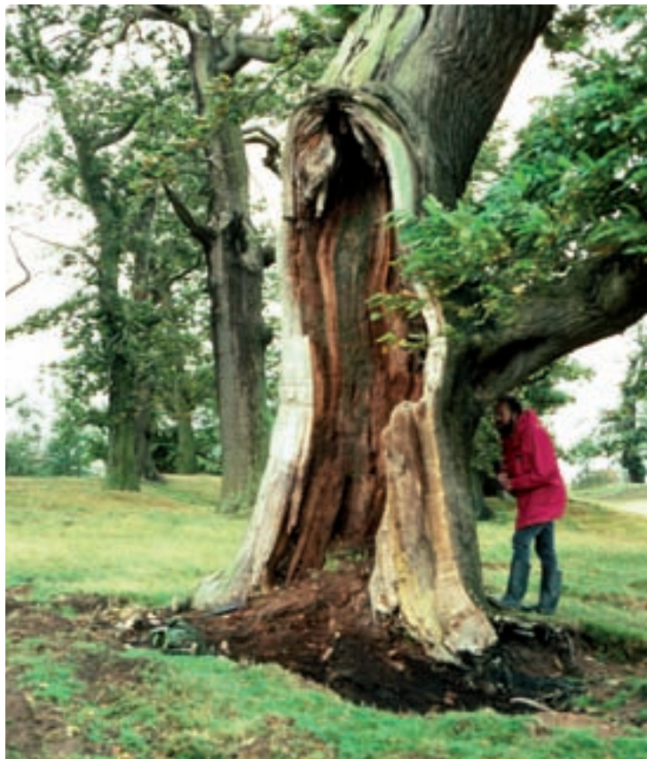
Fig. 5.11: Castaño hueco con pudrición parda, se ve el humus acumulado en su base.
