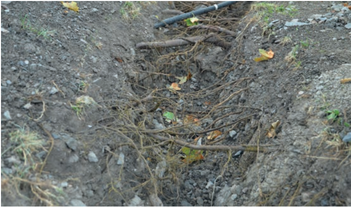
Foto 7. Trazado de una zanja efectuada con la lanza de aire para cables eléctricos cerca de un nogal ( Juglans cinerea ). Las raíces -sobre todo las finas absorbentes, son de color amarillo tal como podéis ver en la foto.
