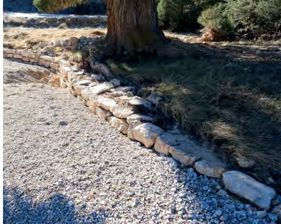
Fotografía 3. Murete de protección contra la socavación que genera la Rambla de la Puebla, a los pies del ejemplar. Autor: R. Barberá.
