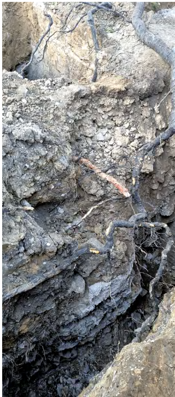
Fotografía 1. Colonización radicular del suelo urbano, una mezcla histórica “tierra y piedra” hecha de capas de residuos de demolición. Foto: Atger C., Pousse Conseil.
